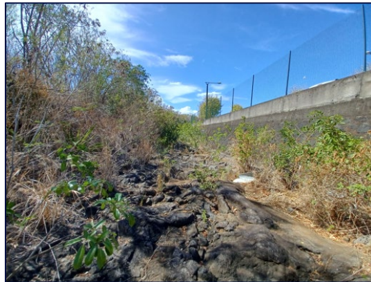
Figure 34: Vue Point rejet dans Ravine des Roches
