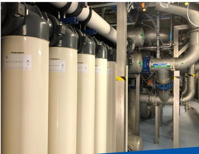
L'usine de pré-traitement des eaux du Bras de la Plaine, réalisée par le Département en 2019, permet d'abattre la turbidité de l'eau à 10 NTU (unités de turbidité néphalométriques) avant son entrée dans l'UTEP de Dassy.
