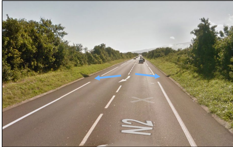
Figure 13: Vue RN2 et évacuation des eaux de ruissellement (source : google maps)
