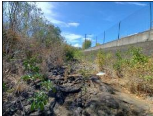
Figure 76: Vue Point rejet dans Ravine des Roches
