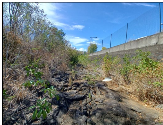
Figure 19: Vue Point rejet dans Ravine des Roches
