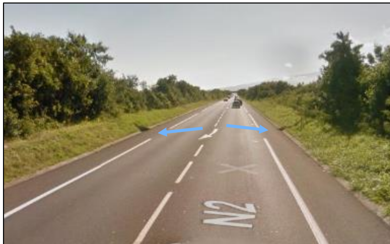
Figure 18: Vue RN2 et évacuation des eaux de ruissellement (source : google maps)
